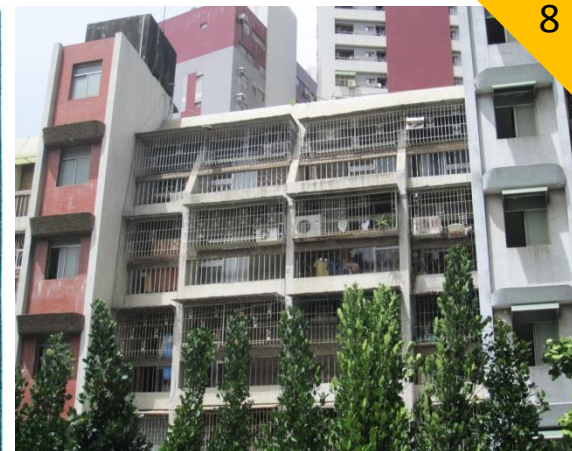
■高市一公寓大火(下圖)·一名男童(左圖)逃生時從6樓墜至2樓遮雨棚，送醫無礙。侯昌騰攝
